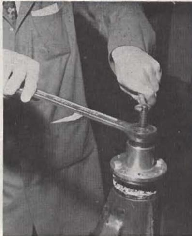
Dépose de la bride d'entraînement à l'aide de l'outil Réf. 09557-22021.
